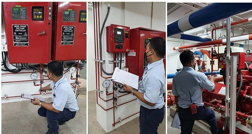
ภาพที่ 3-45 ตรวจสอบระบบป้องกันอัคคีภัยและเครื่องปั้มน้ำดับเพลิง
