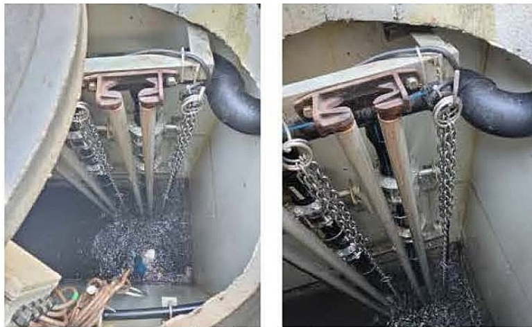
ตรวจสอบท่อทางส่งของปั๊มสูบน้ำออก มีการรั่วบริเวณรอยเชื่อมต่อของท่อ PE
