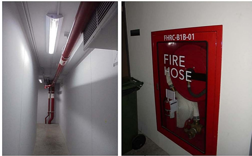
ภาพที่ 3-21 ท่อเย็นและตู้เก็บสายฉีดน้ำดับเพลิงพร้อมอุปกรณ์
