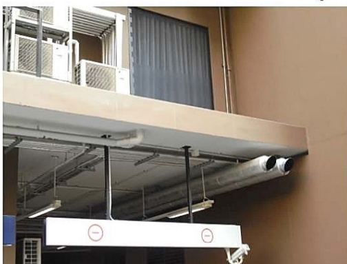
ภาพที่ 3-17 ท่อไอเสียจากห้องไฟฟ้าถูกเงิน ปล่อยออกมาตรงกับต้นไม้ยืนต้นข้างรั้วโครงการ
