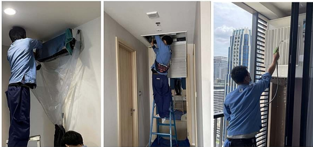
ภาพที่ 3-44 ล้างทำความสะอาดเครื่องปรับอากาศส่วนกลางประจำอาคาร
