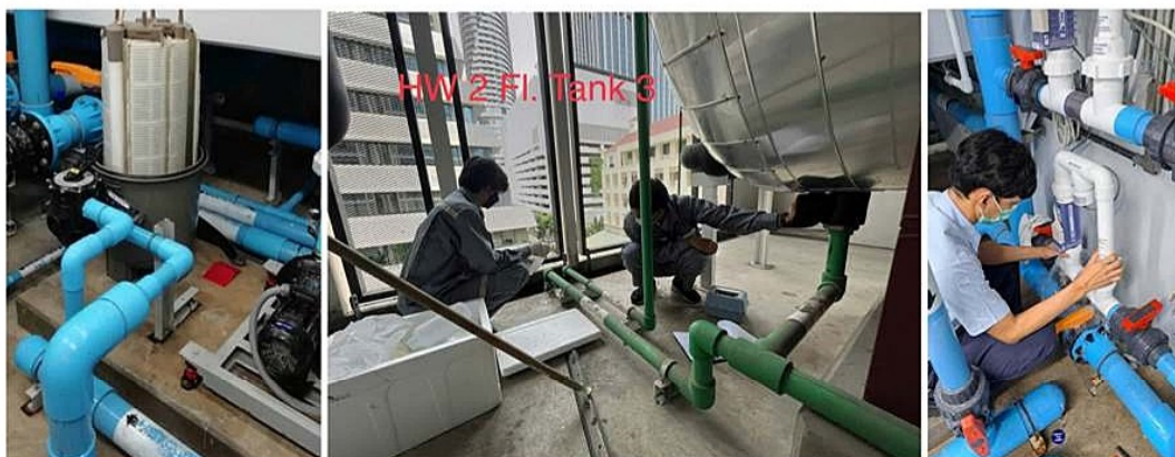
ภาพที่ 3-46 ตรวจสอบถังสำรองน้ำ วาล์วน้ำ ไม่มีจุดรั่วซึม
