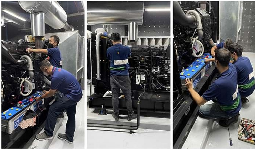
ภาพที่ 3-47 ตรวจสอบและบำรุงรักษาระบบไฟฟ้าสำรองฉุกเฉิน
